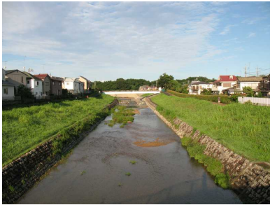
草本植生を備えた直線化区間
